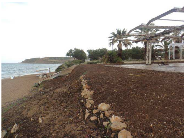
Φωτ. 13: Ανακατασκευή παλιάς γκρεμισμένης επιχείρησης εστίασης στη Σκαλέτα Ρεθύμνου στον πυρήνα ωτοκίας.
